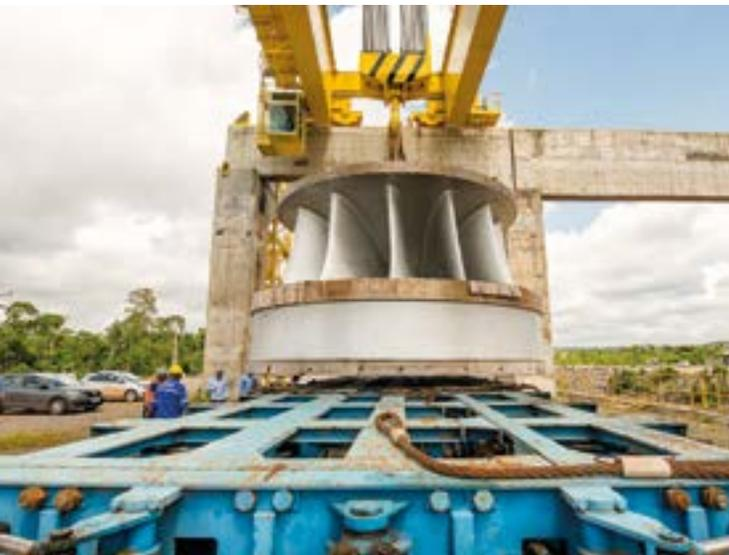
UHE Belo Monte, que impressionam pelo tamanho e peso: o Rotor da Turbina, que pesa 320 toneladas; o Transformador da Unidade Geradora, que chega a 270 toneladas (sem óleo e acessórios), e o Eixo da Turbina, com 112 toneladas. A soma das três peças, 702 toneladas, pode ser equiparada ao peso de quase 878 carros populares (considerando que um único carro básico tem cerca de 800 kg).
